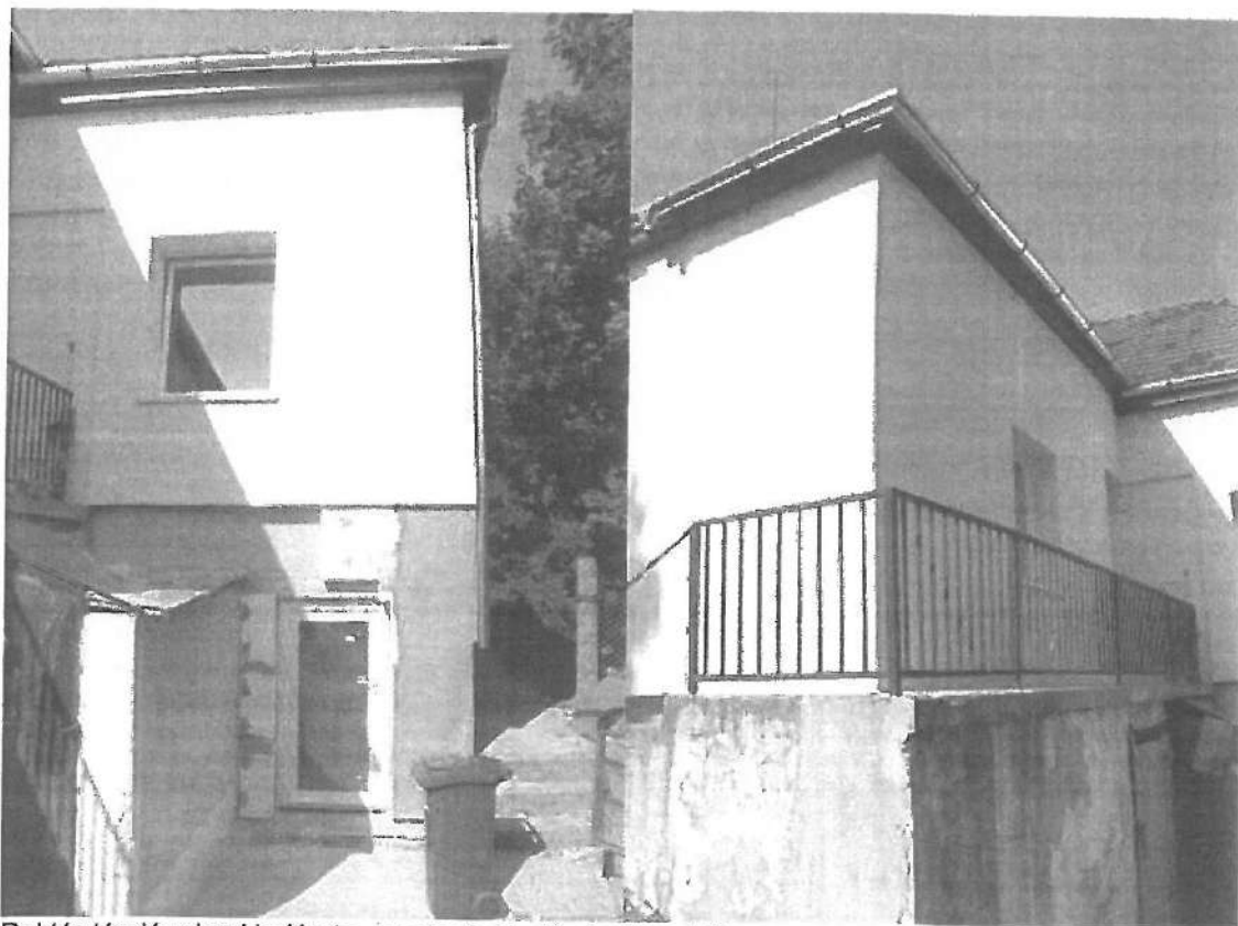
Raktár-tároló udvari bejárata, gazdasági bejárat a konyhához
