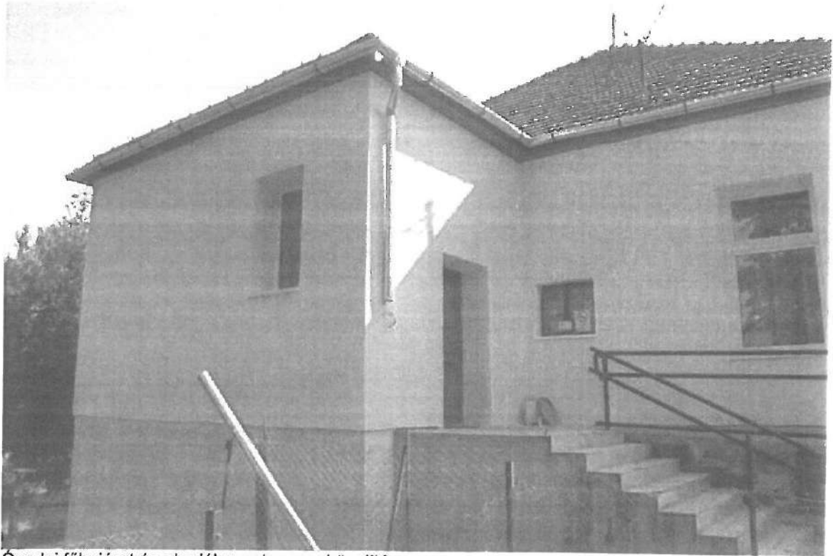
Óvodai főbejárat és akadálymentes megközelítés
